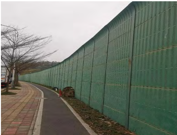
平大路南侧军事基地间隔音屏现状
