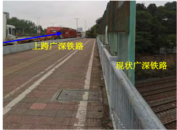
平大路上跨广深铁路现状
