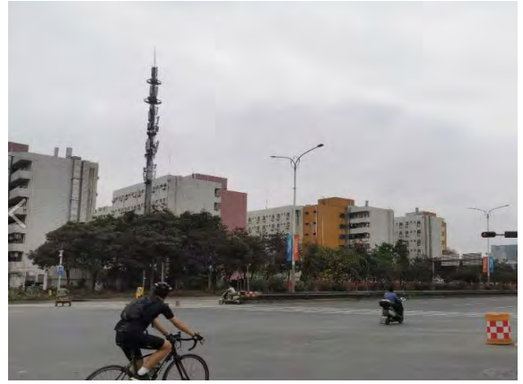
平大路南侧领益智造宿舍现状
