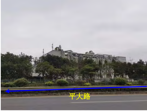
平大路南侧罗山工业厂房现状
