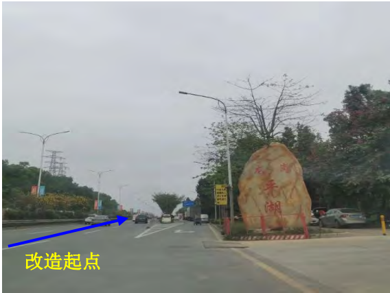
平大路起点现状（龙华与龙岗分界线）
