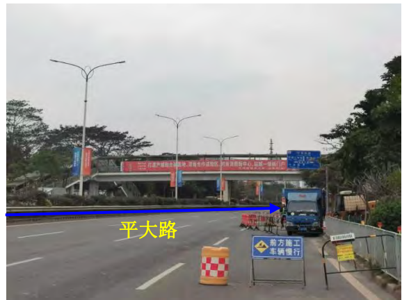
平大路现状人行天桥（拟拆除重建）
