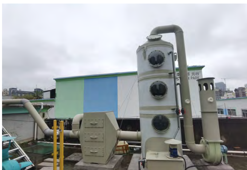
图 3-2 实验室废气处理设施现状图
