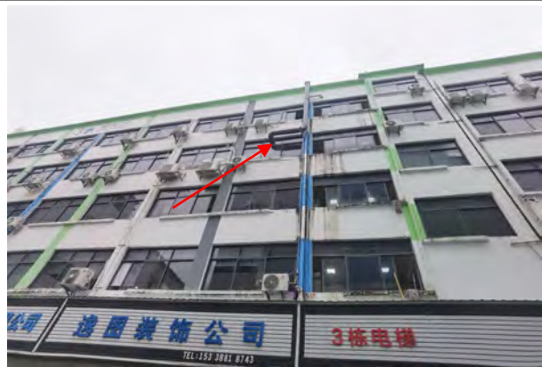
4 楼废气排气管道（引至楼顶）
