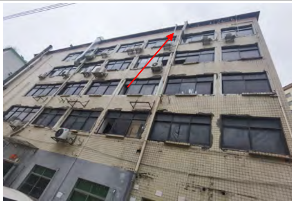
5 楼废气排气管道（引至楼顶）
