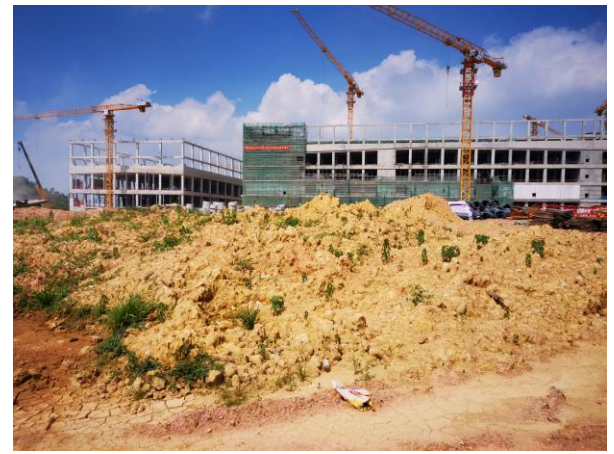
项目西南面鹏芯微在建厂区
