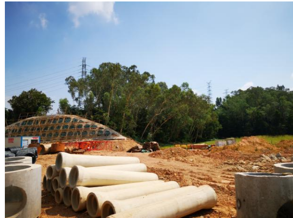
项目西北面鹏芯微在建厂区
