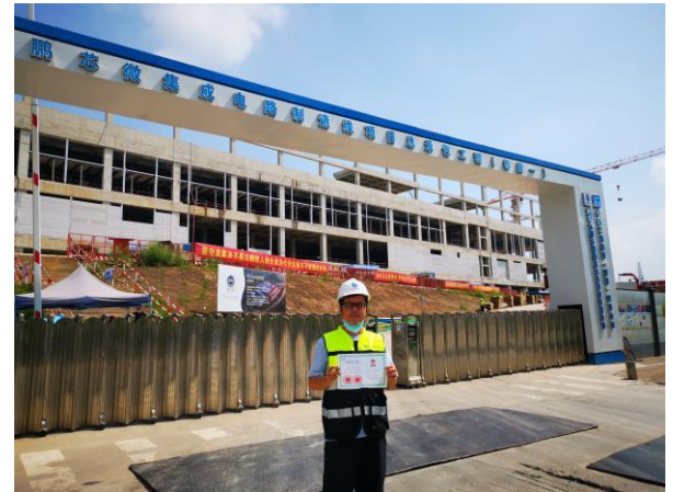
项目负责人现场踏勘
