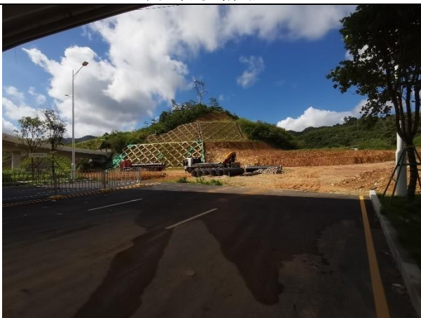
道路终点与在建环坝路交叉口
