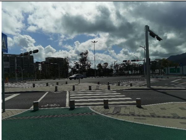
道路起点与新态路交叉路口
