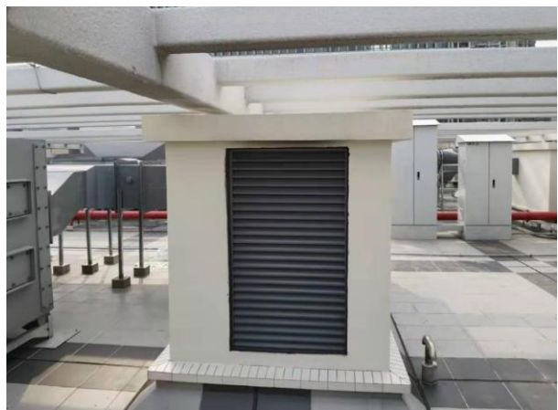
备用发电机排气口
