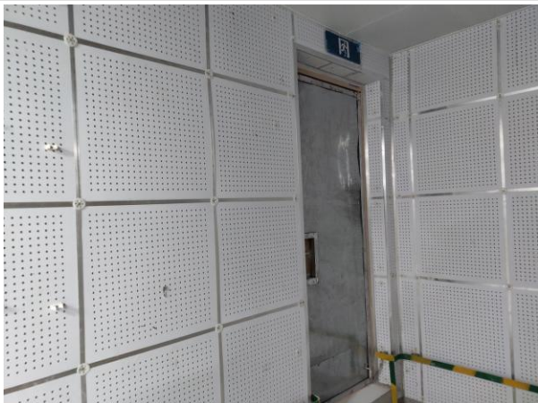
备用发电机房隔声门墙
