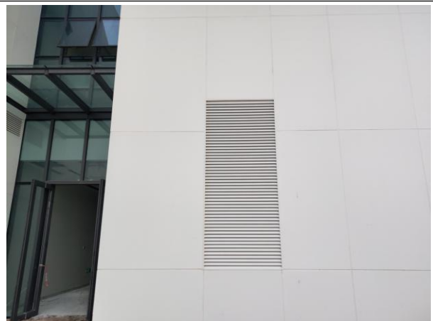
项目地下车库换气口
