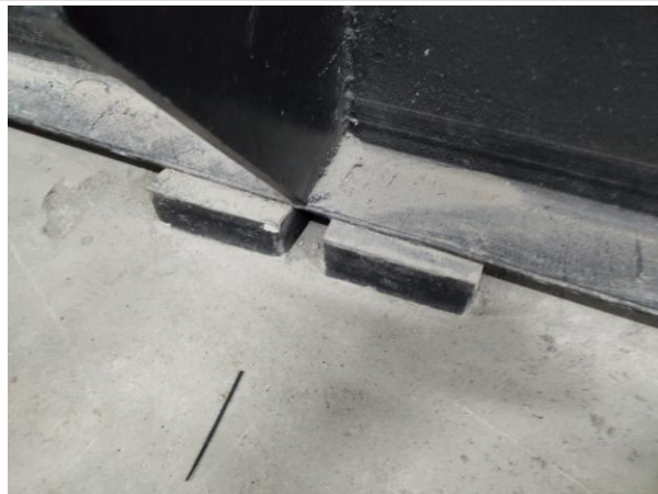
备用发电机减振垫
