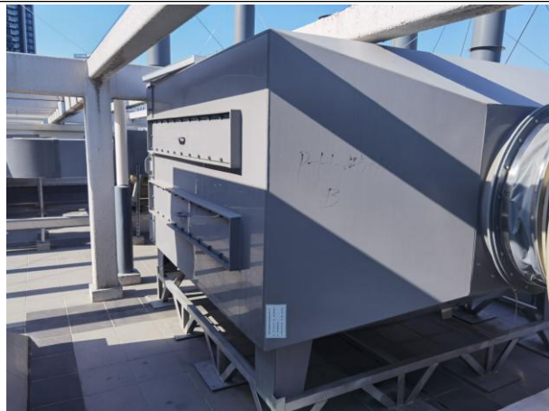
项目废气处理设施
