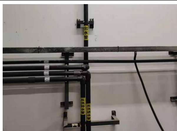
项目废水处理管道
