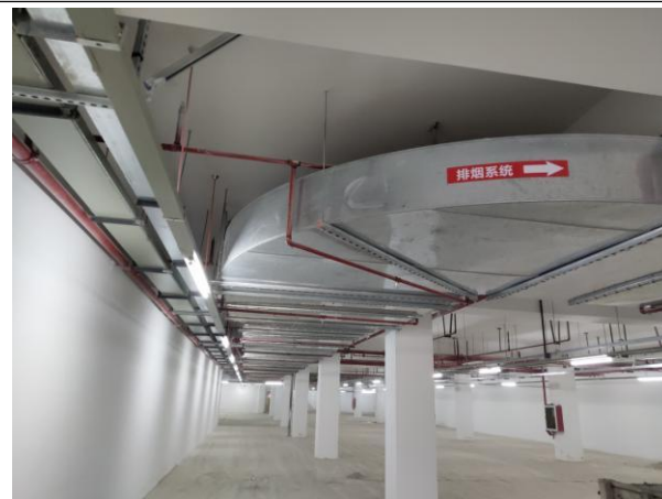
项目地下车库抽排风
