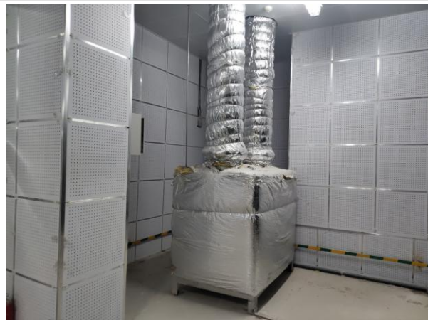
备用发电机尾气处理装置
