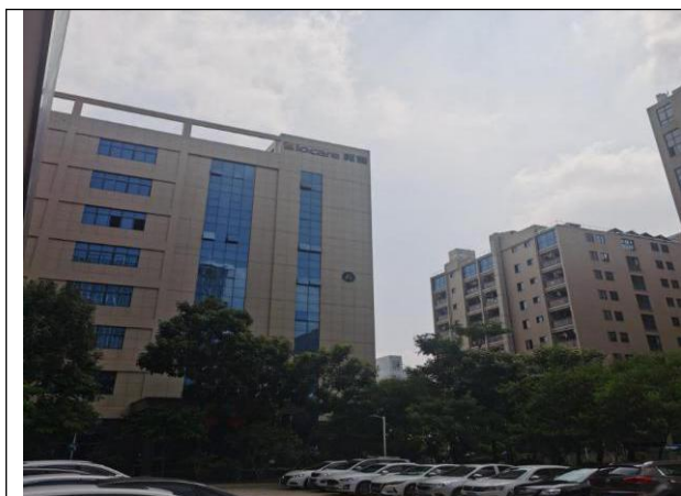
项目东北面---A 栋厂房
