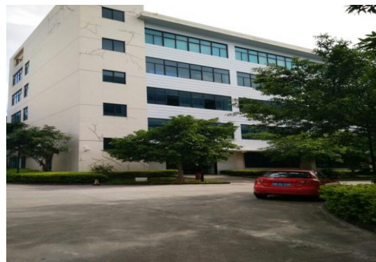
项目西面工业厂房
