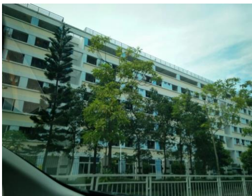
项目东面工业厂房
