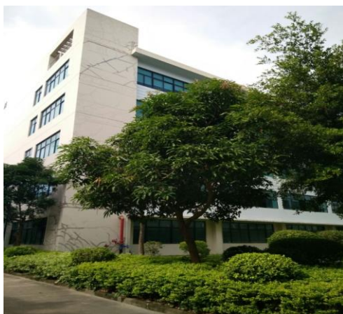
项目北面工业厂房
