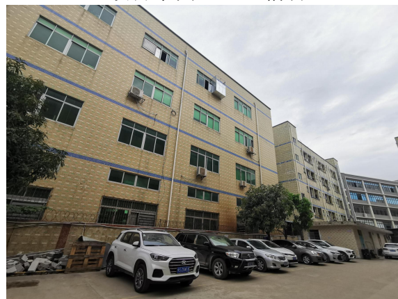
项目北面 工业厂房及宿舍
