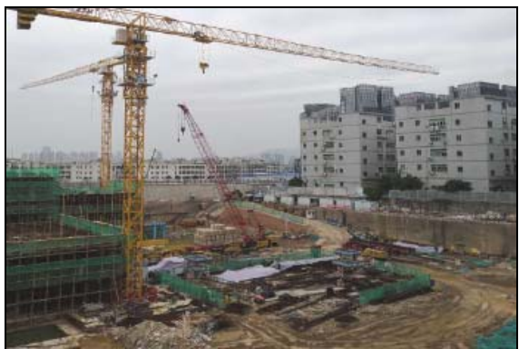
隔风门北路的在建办公楼
