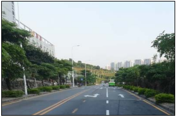
项目东北侧风门北路
