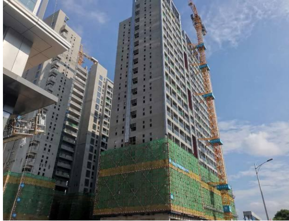
项目南面施工工地
