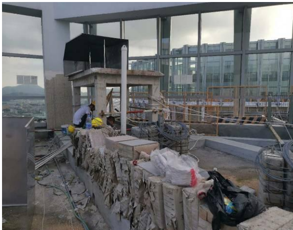
发电机烟气楼顶排放口
