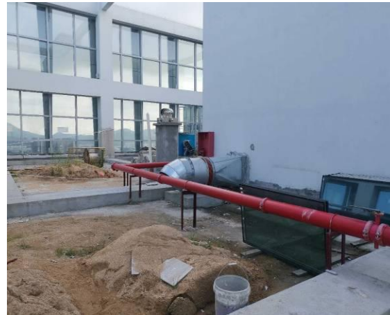
商业餐饮油烟楼顶预留排烟口
