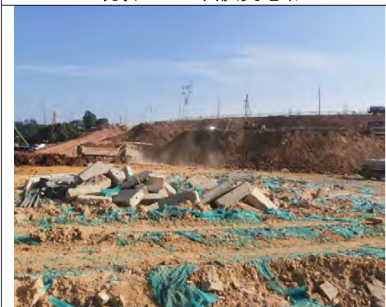
拟建站址东侧 已平整空地
