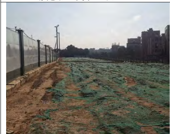
拟建站址西侧 已平整空地
