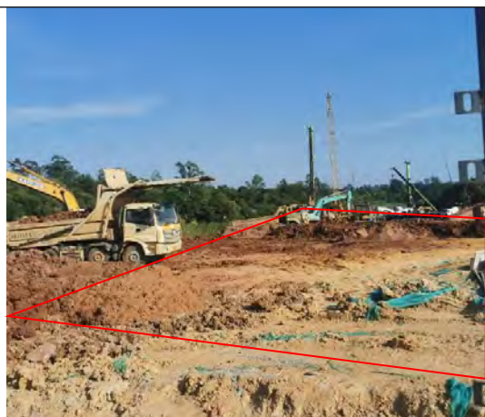
拟建变电站选址现状
