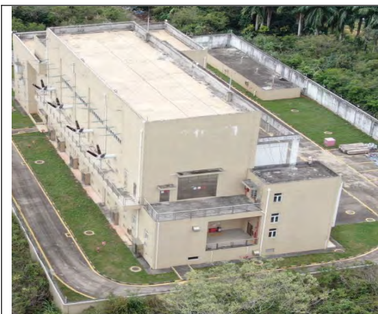
现状 110kV 同庆变电站
