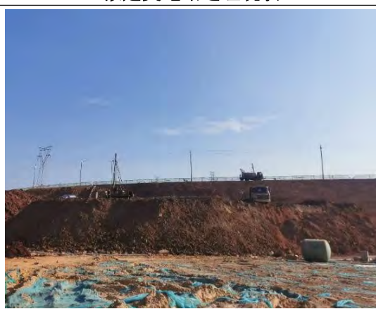
拟建站址南侧 已平整空地
