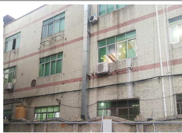
项目东面---工业厂房
