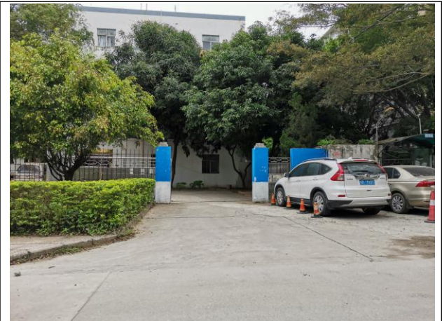
项目北面---工业厂房
