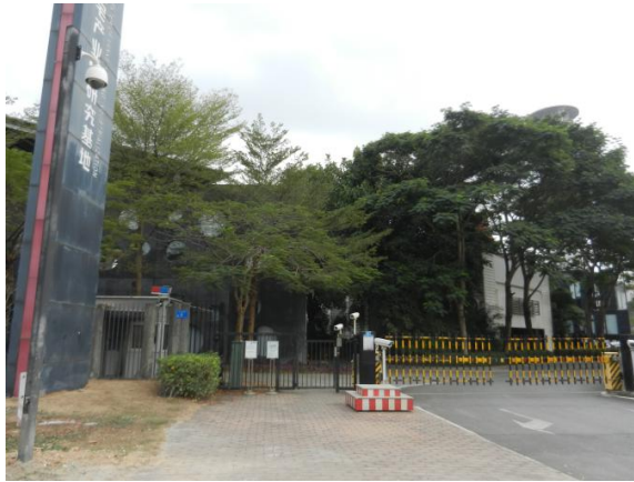
18#, 线路东侧 2m 的万科住宅产业化研究基地门卫室
