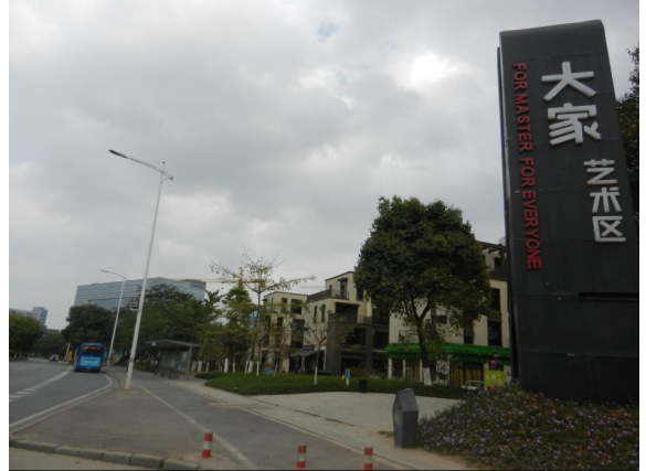
17#, 线路东侧 4m 的大家艺术区 3 层建筑物
