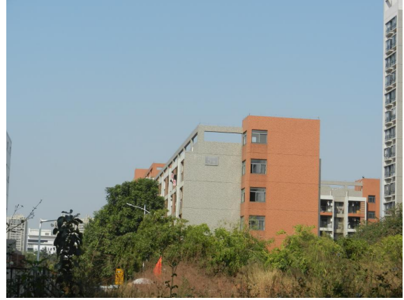
9#, 站址西北侧 14m 的 5 栋 5 层办公楼
