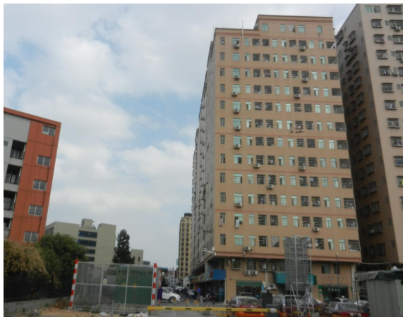
13#, 线路南侧 4m 的 14 层商住楼及 14#, 线路北侧 1m 的 1 层商店 (棚房) ②
