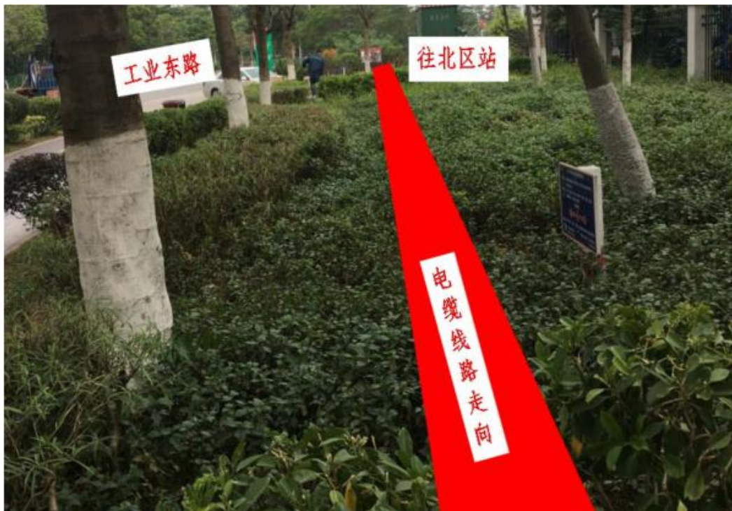
图 1-4 电缆在绿化带下走线
