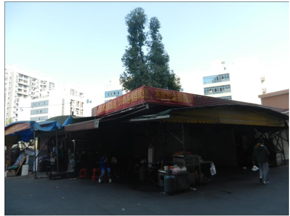
12#, 线路东侧 2m 的 1 层商店 (棚房) ①
