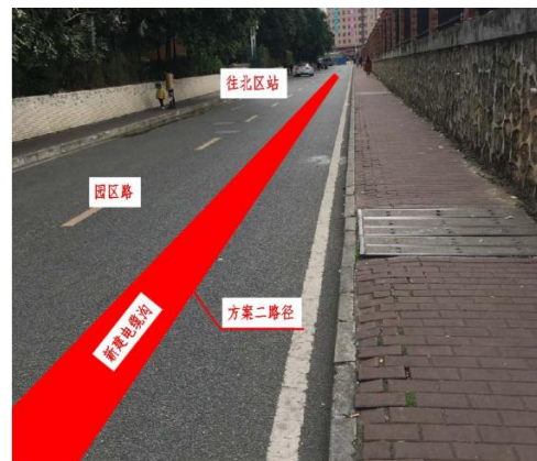
图 1-9 新建线路沿园区行车道走线
