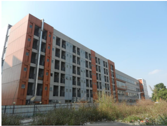
10#, 站址西南侧 14m 的 4~6 层办公楼
