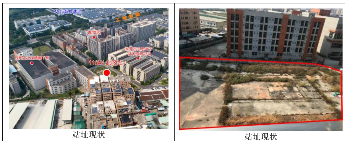
图 1-10 110kV 北区变电站站址及周边环境现状图
