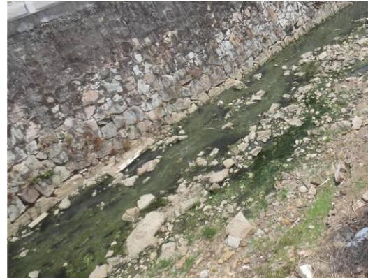
图 22-2 挡墙护脚破损变形
